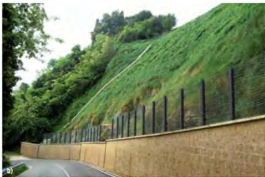
Figura 5. Orvieta (Terni) - SP111 della Badia: a) situazione del versante nel dicembre 2004, prima dell'intervento; b) dopo l'intervento di rinaturalizzazione (luglio 2006).
