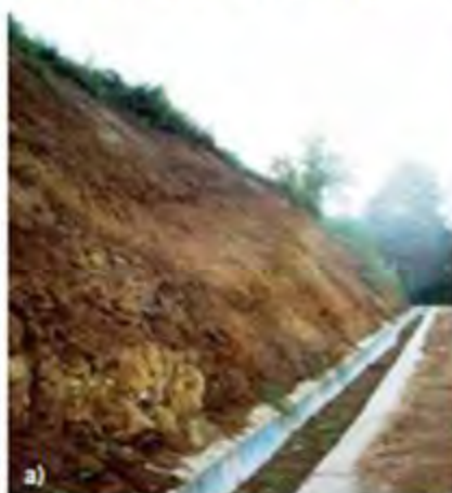
Figura 6. Orvieta (Terni) - SP111 della Badia: a) canaletta intasata (foto settembre 2005); b) canaletta pulita (foto maggio 2006).
